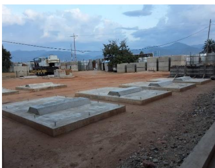
Préfabrication des blocs pour les quais
