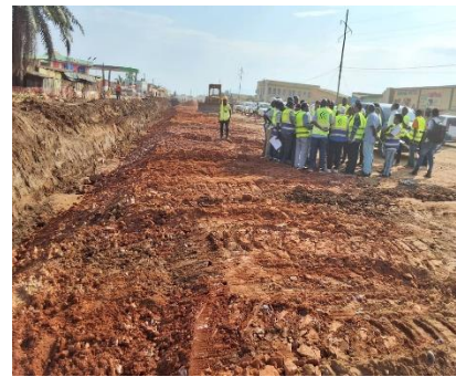
Visite des travaux routiers
